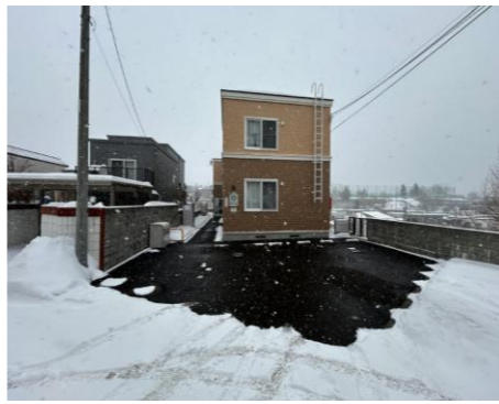
駐車場、アプローチ部分もロードヒーティング!! 冬も安心
